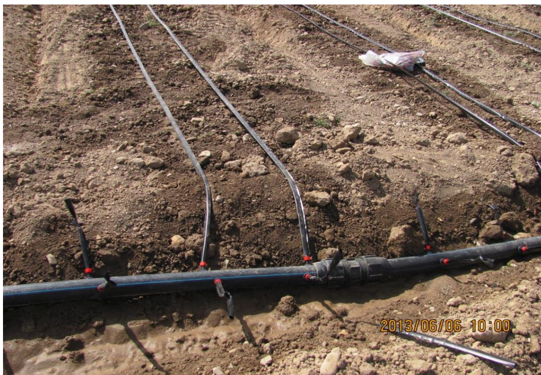
شکل ۱۶- سیستم تیپ جهت آبیاری مزرعه فلفل
